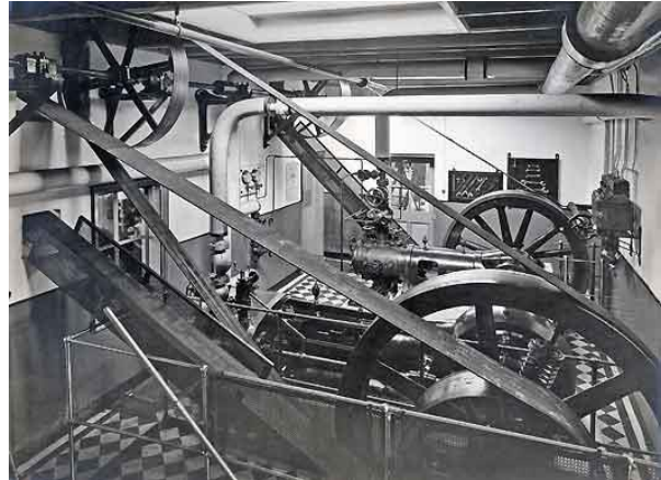
Onze Kleine Stork na 1919. Je ziet hem vooraan. Hier drijft hij nog met poelies en riemen de assen aan. Op de achtergrond staat een koelmachine die ook door de Kleine Stork wordt aangedreven.
